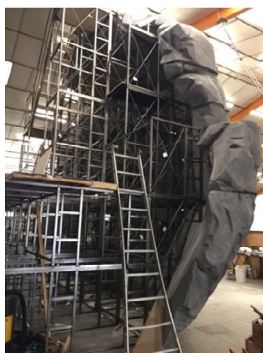
Photos 33, 34, 35, 36, 37 : Mise en place de la structure et fixation au décor
