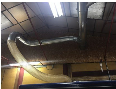
Photo 53 : Aspiration directe pour la machine à commande numérique
